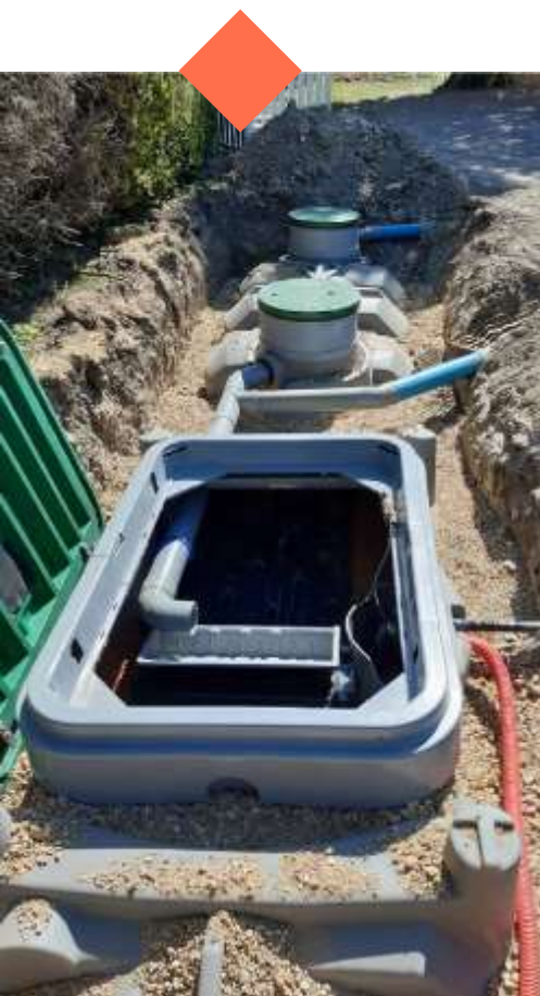
Installation d'ANC chez un particulier Source : SATESE 37
