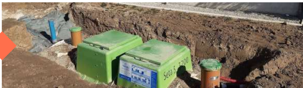
Installation d'ANC chez un particulier - Source : SATESE 37
